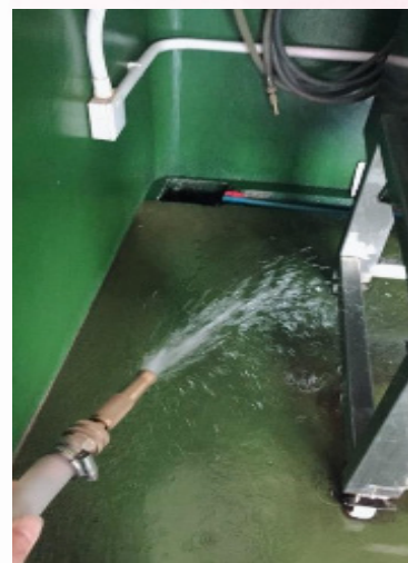
รูปที่ 13 นำน้ำจากแท้งค์บรรจุไปใช้ ประโยชน์ในห้องน้ำ (หลังปรับปรุง)
