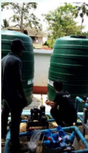
รูปที่ 12 ติดตั้งท่อรวบรวมน้ำทิ้งจากระบบ RO เข้าสู่แท้งค์บรรจุ (หลังปรับปรุง)
