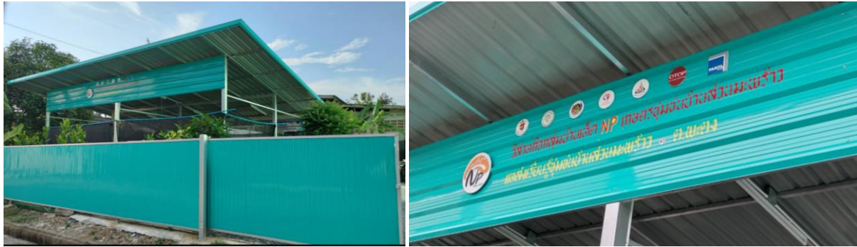
รูปที่ 18 สถานที่จัดตั้งกลุ่มฯ
